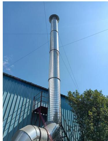
图 4 有机废气排气筒采样平台及监测孔
