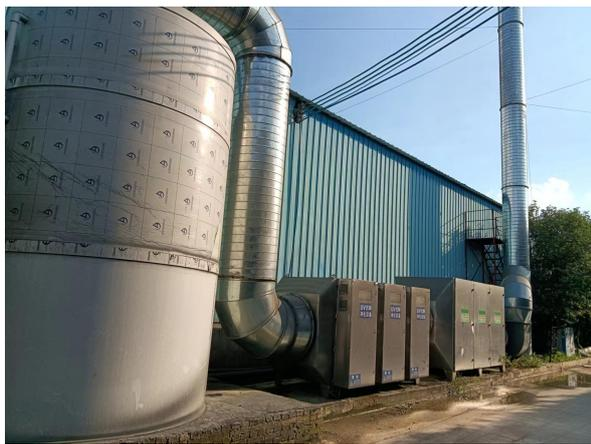
图 3 水喷淋+UV 光解+过滤器+活性炭”设施
