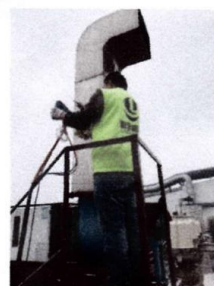
炒馅废气排放口 DA001
