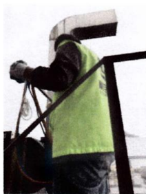
食堂油烟排放口 DA003
