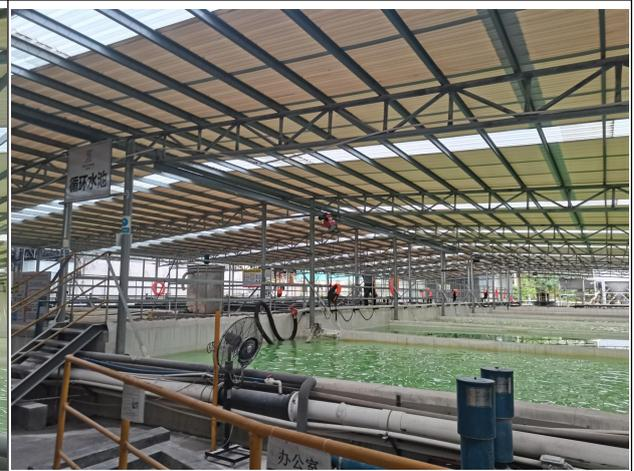
图 3 酸洗废水处理系统(沉淀法)
