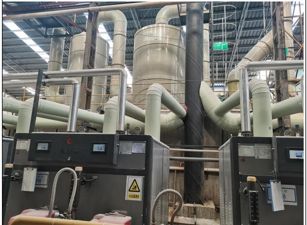
图 6 蒸汽发生器燃烧烟气排气筒 DA006
