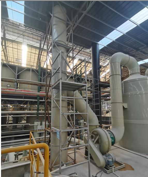
图 5 酸洗废气排气筒 DA005
