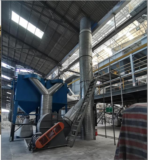
图 4 色选粉尘废气排气筒 DA004
